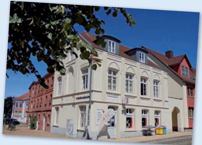
Der RotkreuzSpeicher in der August-Bebel-Str. 51 in Grevesmühlen.
