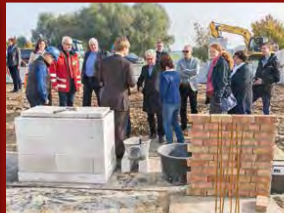
Architekt Lars Schneekloth (Mitte) erläutert die nächsten Schritte für die Errichtung der modernen Pflegeeinrichtung.
